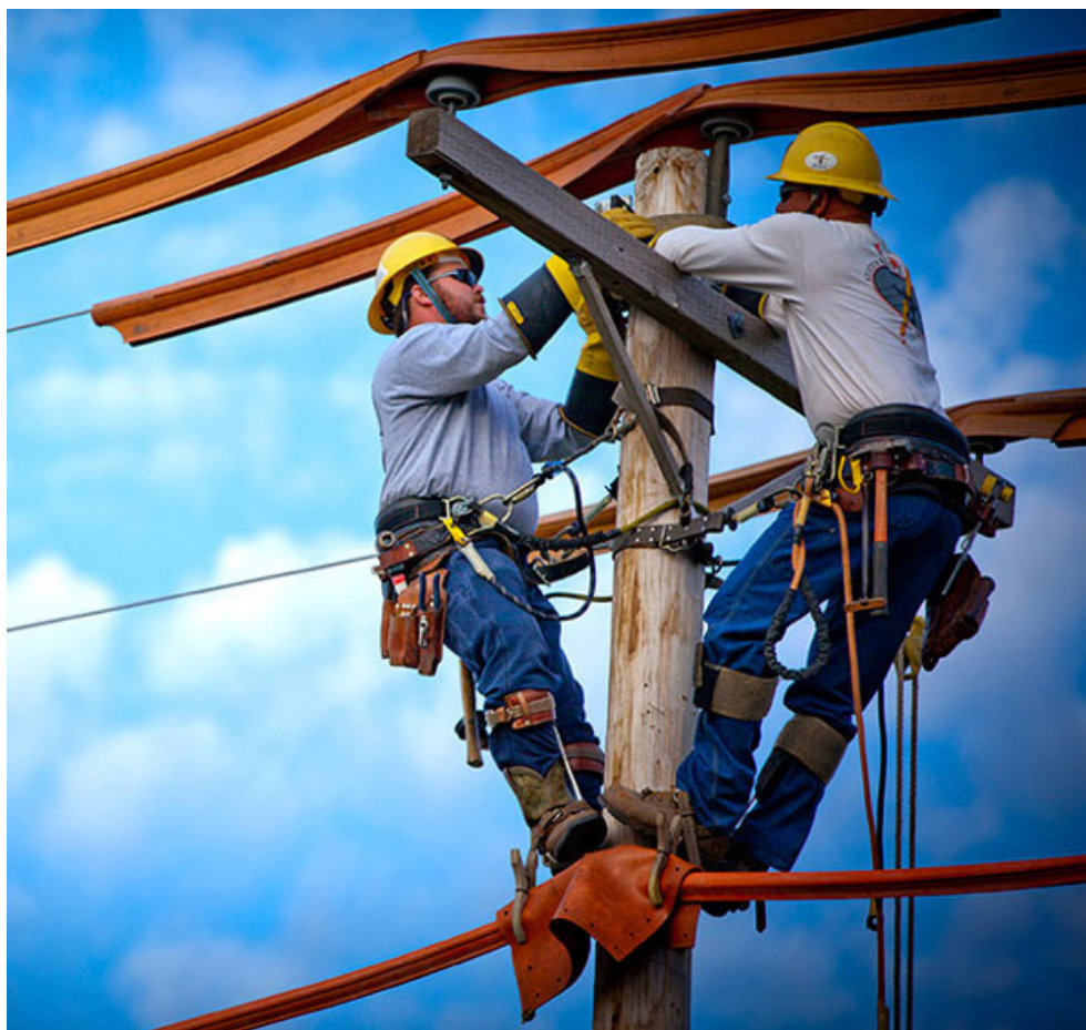
OG&E linemen | OG&E
