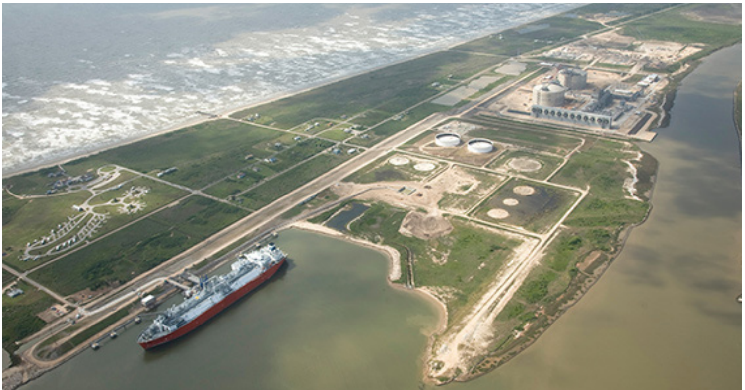
Freeport LNG export terminal | Freeport LNG Development
