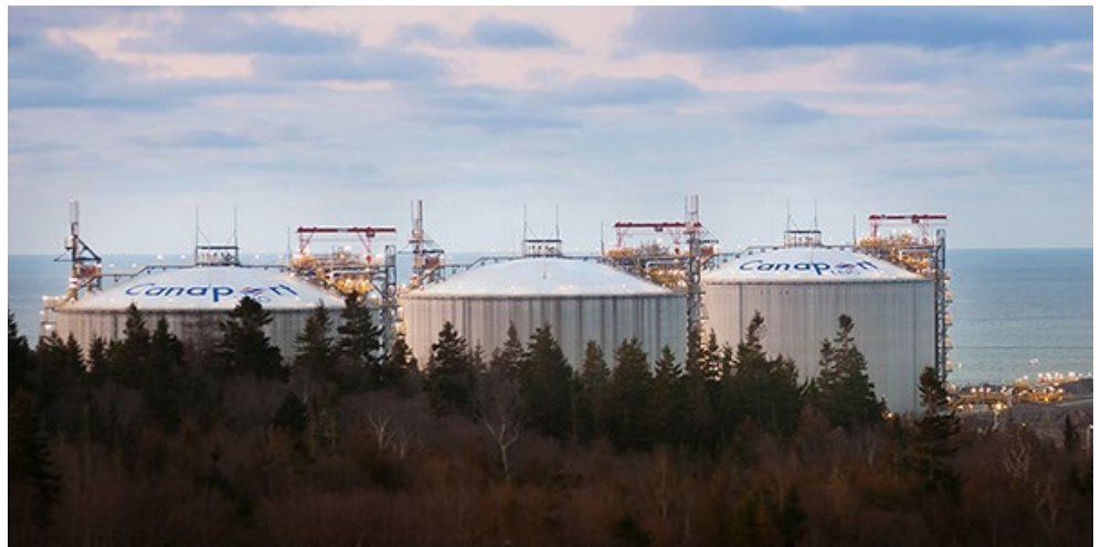
Canaport LNG terminal's three storage tanks | Canaport LNG
