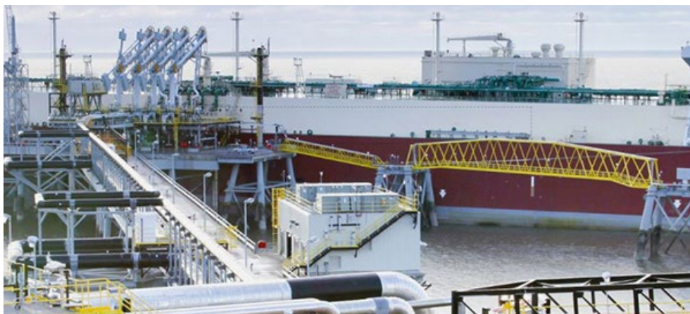
Canaport LNG terminal in Saint John, New Brunswick | Canaport LNG
