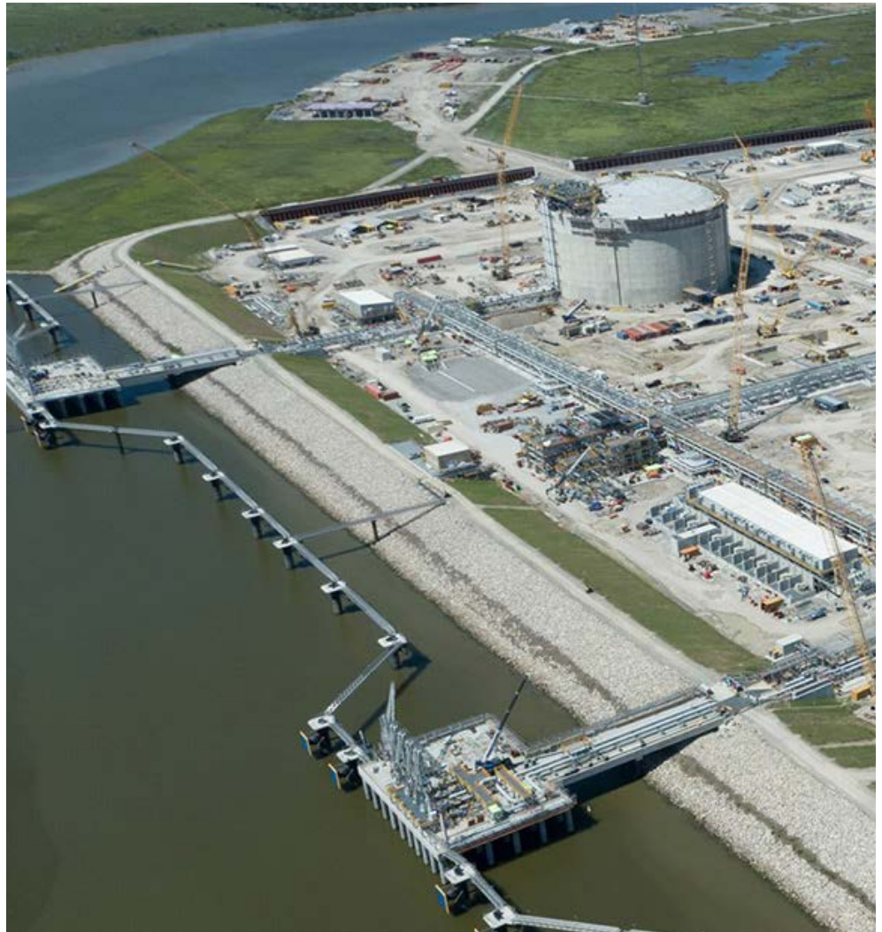
Calcasieu Pass LNG Facility | Venture Global LNG
